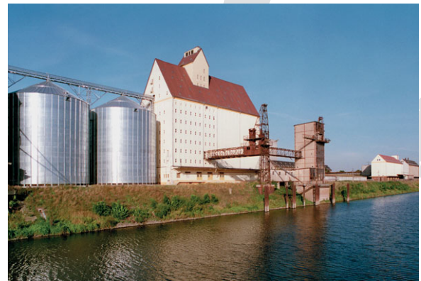
Siloanlage mit Annahme 2x140 t/h, Halle Hafen
